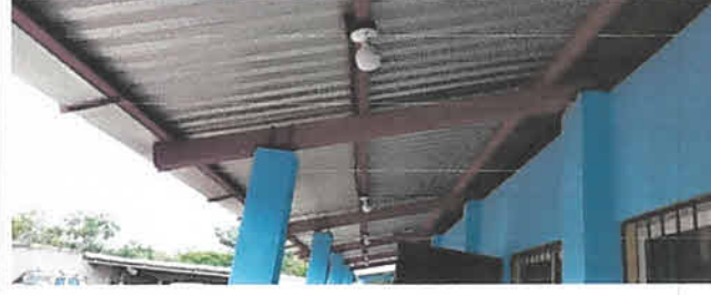
Foto 6: Reparación de sistema eléctrico incluye plafoneras, focos y apagador, y un timbre.
