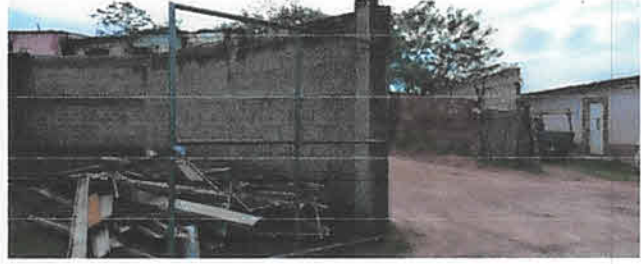
Foto 4: Reparación de porton, cambio de malla por lamina, pintura, pasador y candado medida de 5*2.50mts.
