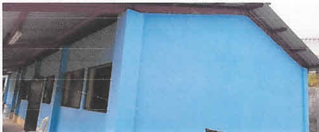
Foto 3: Aplicación de pintura en muros interior y exterior.
