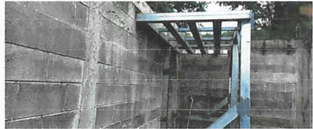
Foto 2: Instalación de tinaco rotoplas capacidad 5 toneles
