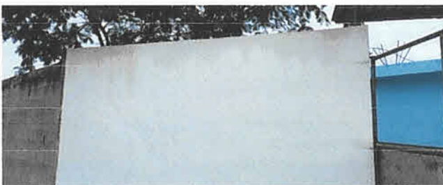
Foto 5: Aplicación de repello en paredes al lado del porton.
