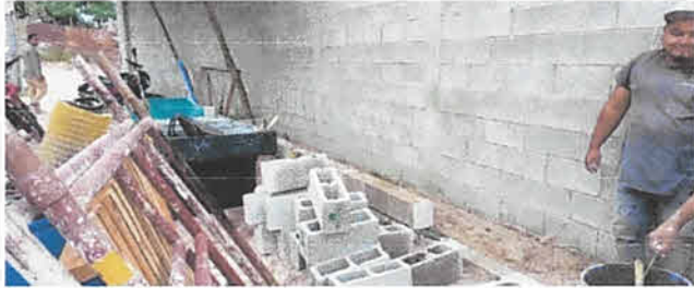
Foto1: Elaboración de banqueta de block, 60cm de altura, 60cm. De ancho
